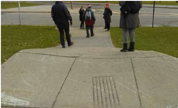
Photo 4: Pente très forte dans le parcours
