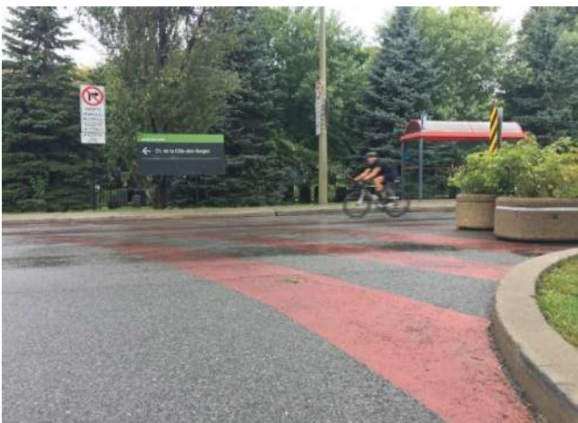
Photo 9: Parcours piétons et cyclistes non séparés, pots à fleurs nuisant à la visibilité
