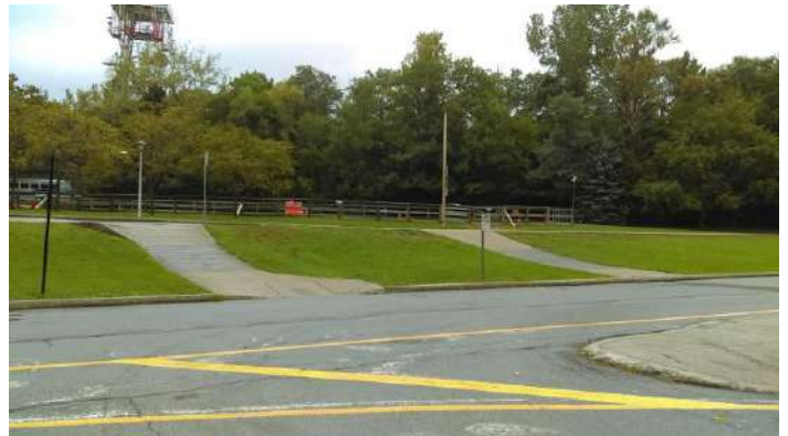
Photo 5: Désalignement du parcours et absence de passage piéton
