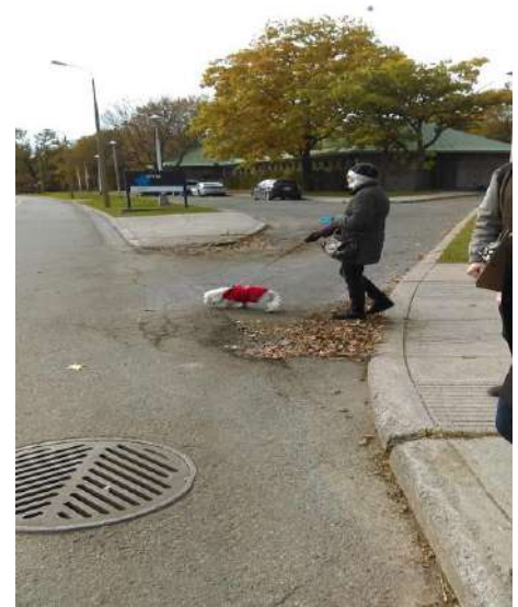
Photo 3: Absence de bateau-pavé et de traverse piétonne
